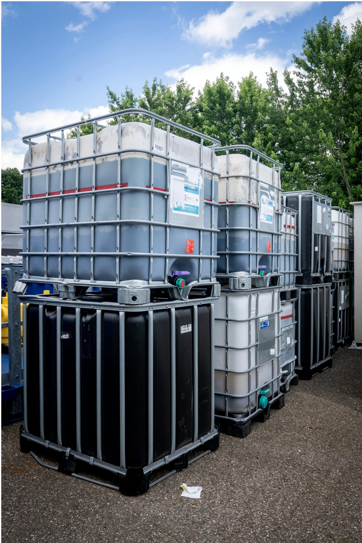
Achttien tanks met bacteriën die mest kunnen omzetten in biogas. Foto Eric Brinkhorst
